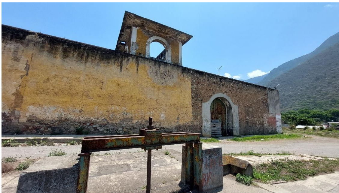
Fotografía 50. Muro lateral de la fábrica San Lorenzo
