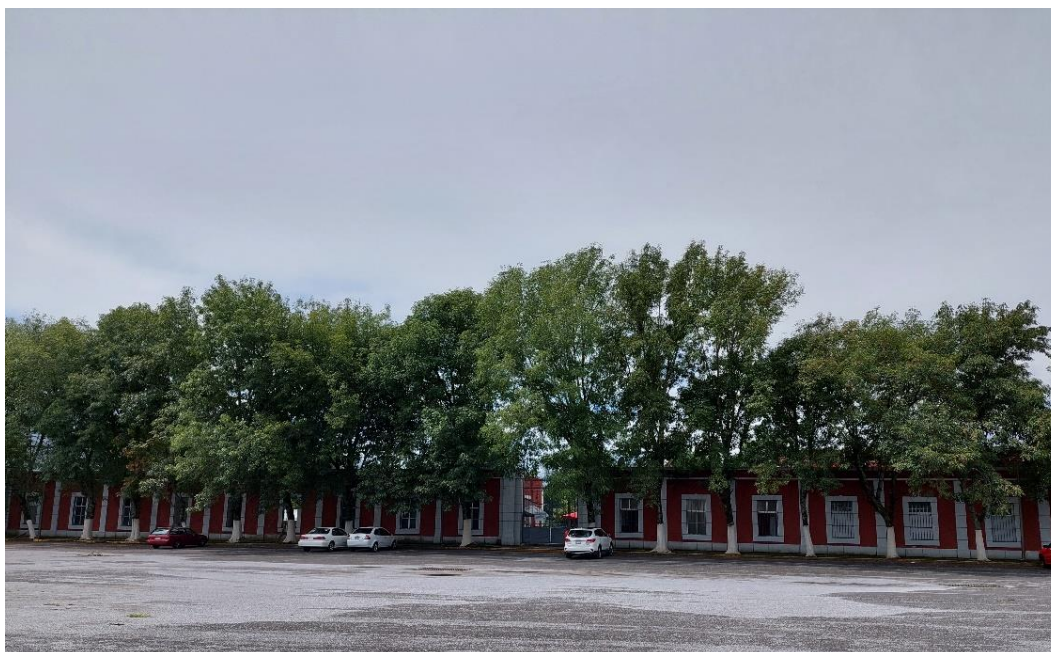
Fotografía 52.Exterior de la Fábrica Santa Gertrudis
