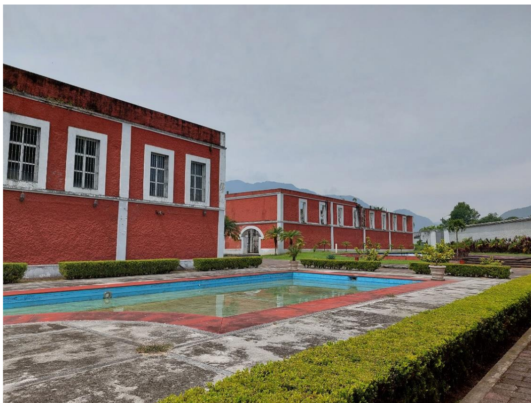
Fotografía 51. Interior Fábrica Santa Gertrudis
