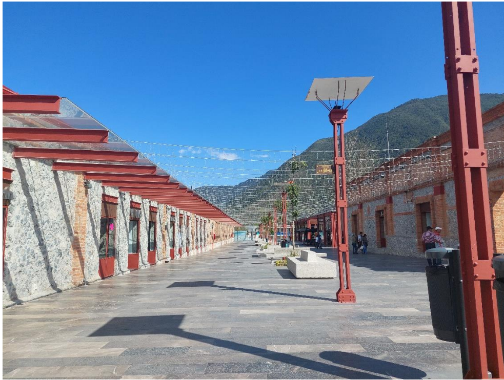
Fotografía 45. Interior del Centro Comercial Punto Santa Rosa
