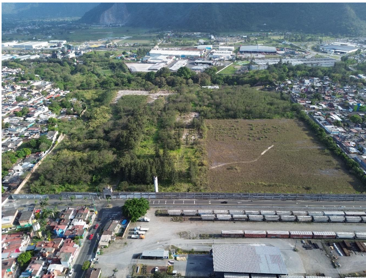
Fotografía 41. Muro perimetral de la Fábrica Cocolapan, de Orizaba
