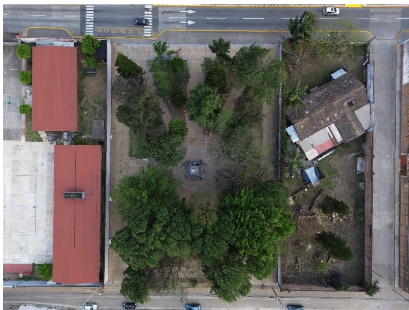
Fotografía 57. Vista aérea del Parque Centenario de Río Blanco
