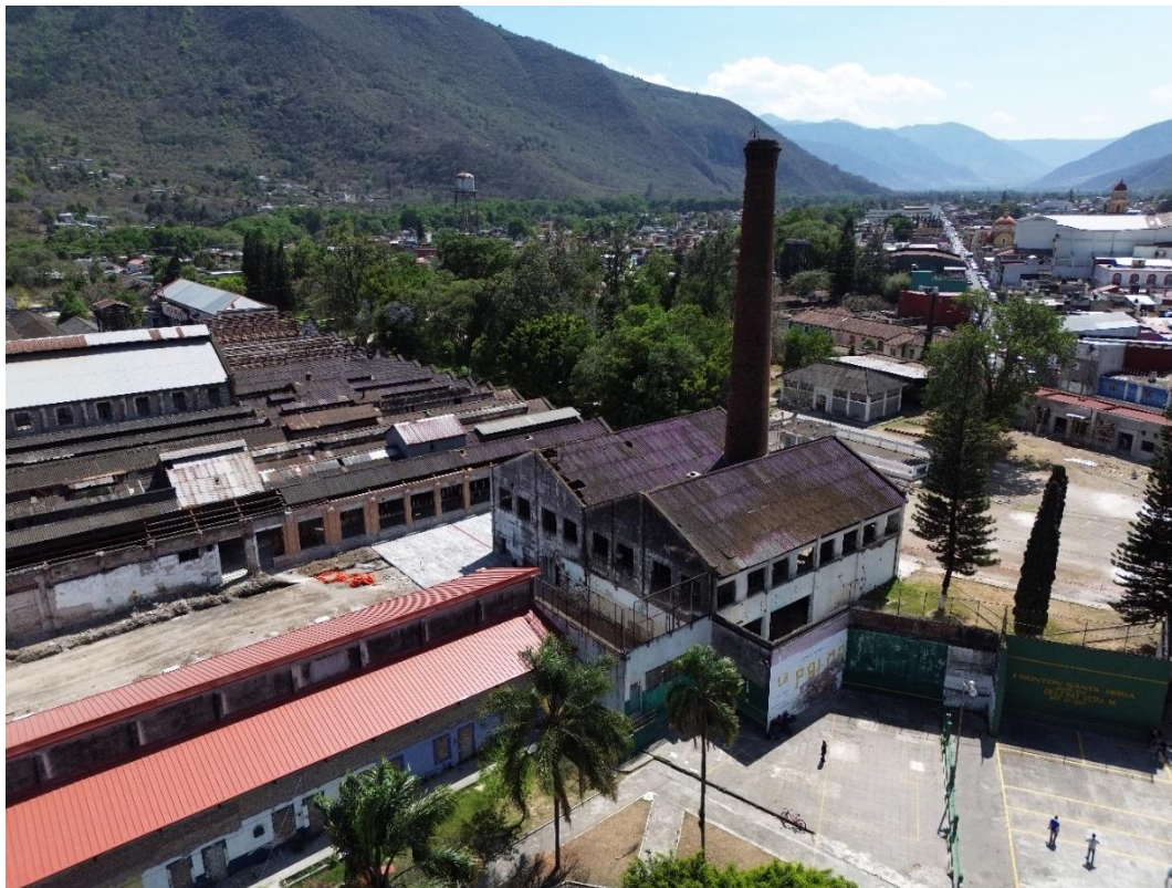
Fotografía 2. Vista actual de la Fábrica Santa Rosa
