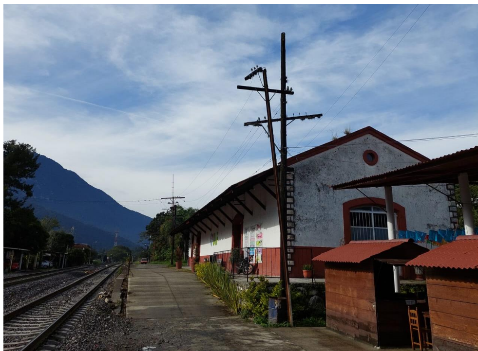
Fotografía 54. Estación de tren de Nogales
