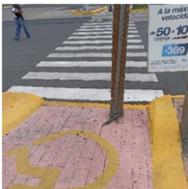
Imagen 6. Fotografías del estado de las rampas sobre Jesús García
