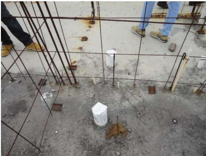
**Fotografía 10.** Estructura de acero para la edificación del baño de dos viviendas de un nivel del Fraccionamiento Arvento.
