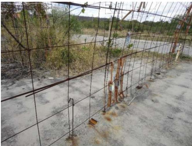
**Fotografía 11.** Estructura de acero para la edificación de un muro de carga en vivienda de un nivel del Fraccionamiento Arvento
