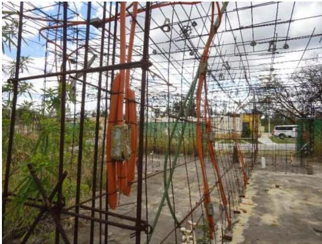
**Fotografía 9.** Estructura de acero para la edificación de un muro de carga con la instalación de red eléctrica en vivienda de un nivel del Fraccionamiento Arvento
