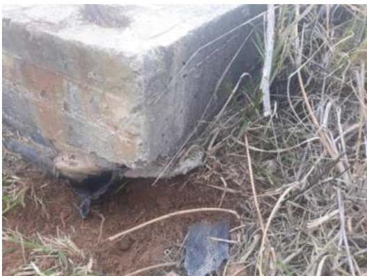
**Fotografía 5.** Losa de cimentación para vivienda de un nivel del fraccionamiento Arvento, hecha de hormigón recostada sobre plástico para evitar la filtración de la humedad del terreno lacustre.
