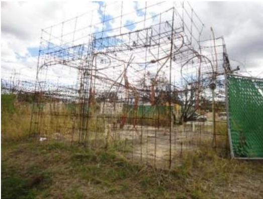
**Fotografía 3.** Estructura de acero para la edificación en vivienda de un nivel del Fraccionamiento Arvento.
