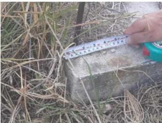
**Fotografía 4.** El soporte del muro de carga es una varilla de acero de media pulgada recubierta por 4 cm de cemento de cada lado, en vivienda de un nivel del Fraccionamiento Arvento
