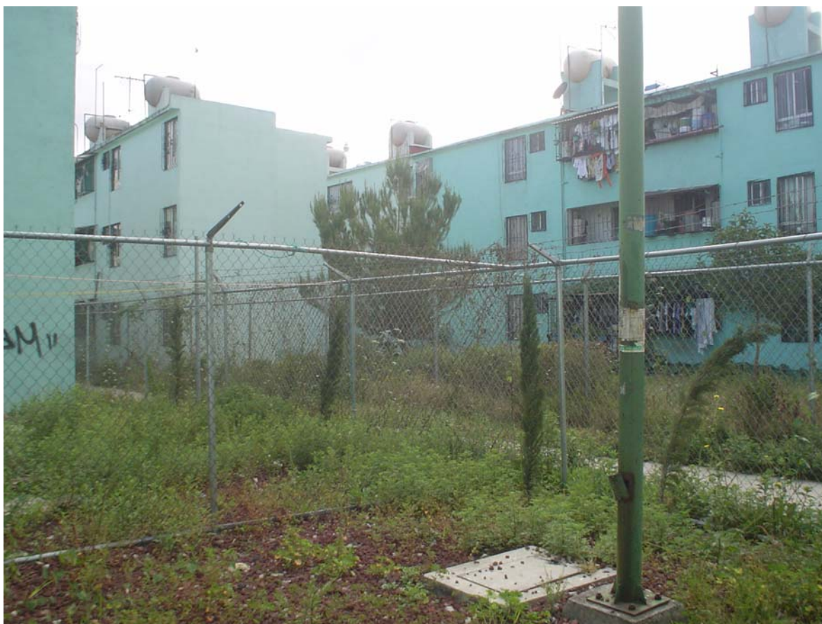
FOTO 36: MALLA CICLÓNICA ALREDEDOR DE EDIFICIOS. IRMA HERRERA MAYA. MARZO, 2004.
