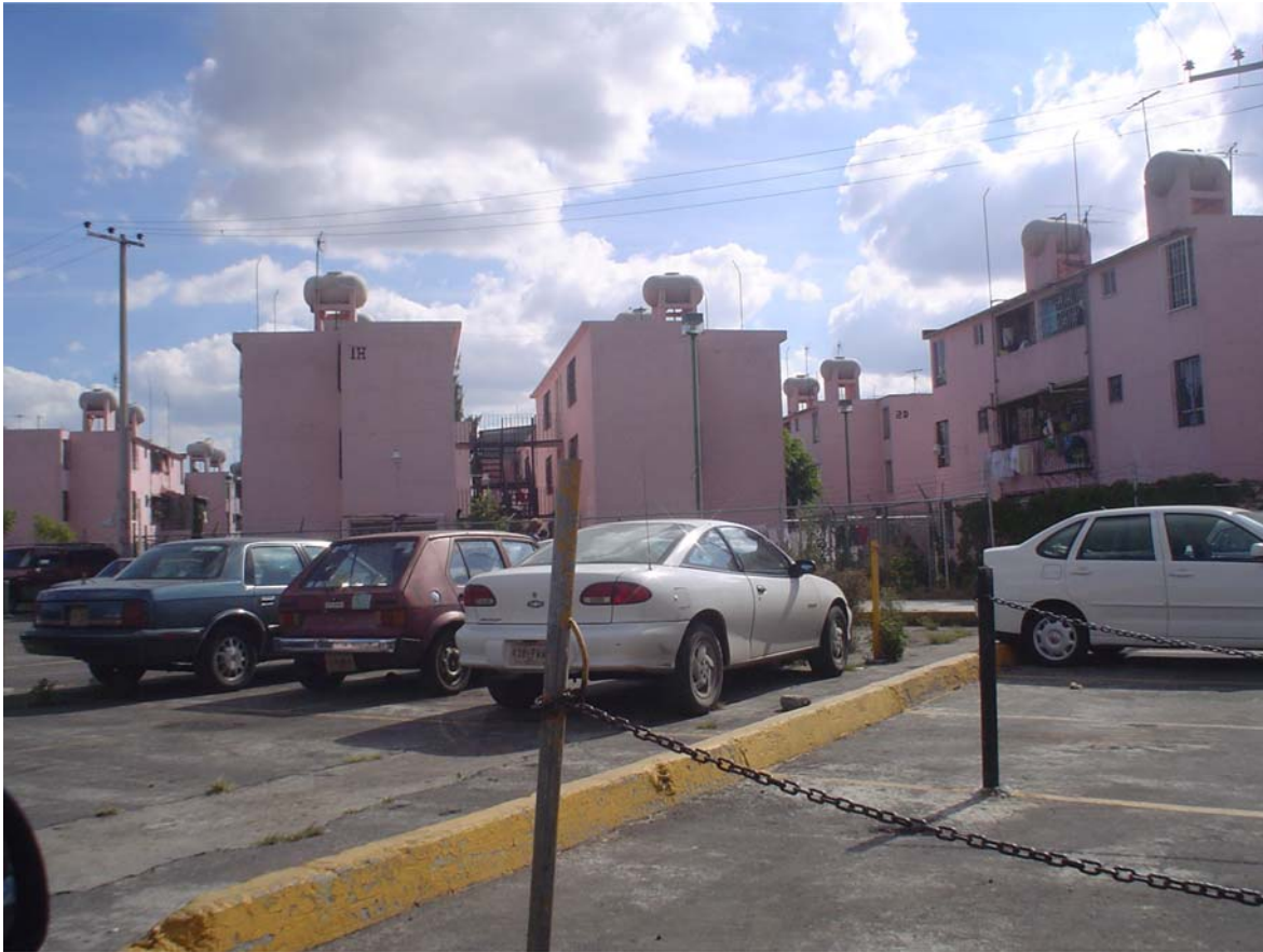
FOTO 33: DIVISIÓN EN PLENO ESTACIONAMIENTO PARA IMPEDIR EL PASO HACIA OTRO SECTOR. IRMA HERRERA MAYA. MARZO, 2004.
