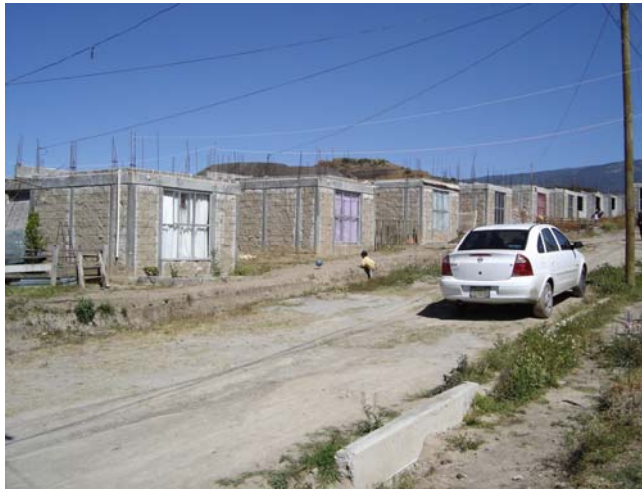
Viviendas del Fraccionamiento José Guadalupe Posada, 2006
